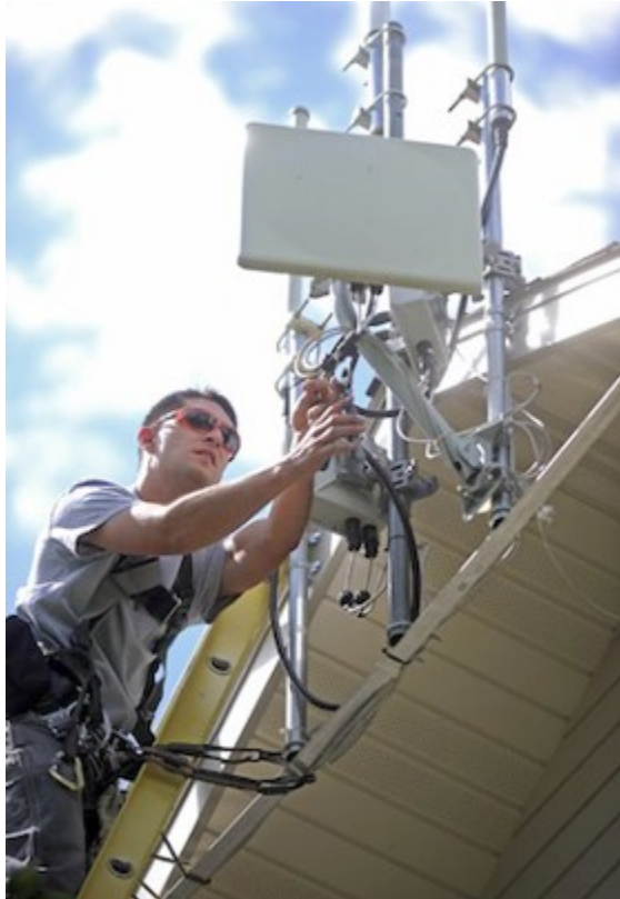
UMTS bázisállomás telepítés
